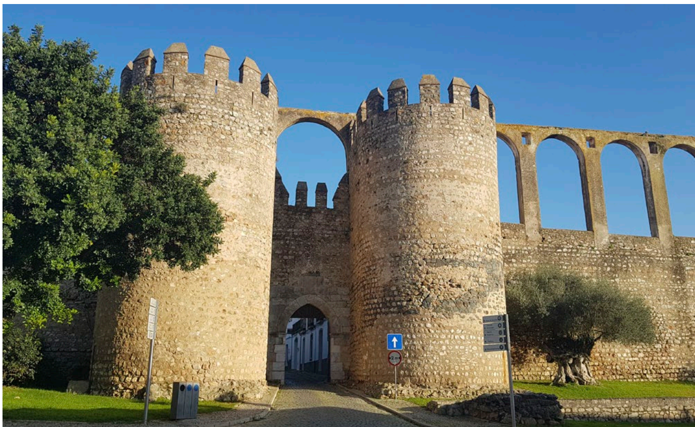
Aqueduto de Serpa
